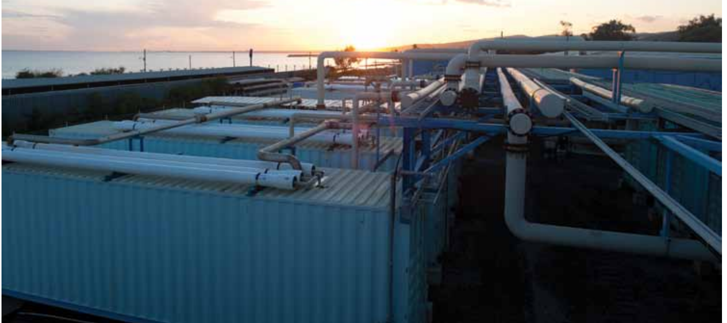
חלקיה המרכזיים של מערכת ההתפלה מותקנים על המכולות (מתקני ה-UF, מתקני האוסמוזה ההפוכה, משאבות לחץ גבוה, ומתקני השבת אנרגיה)
